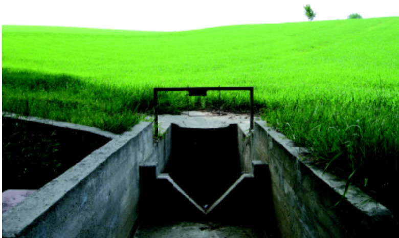
Rys. 5. Przepust przelewowy (konstrukcji E. Nowocienia) u wylotu mikrozelewni w Rogalowie Fot.: J. Jadczyzyn.
